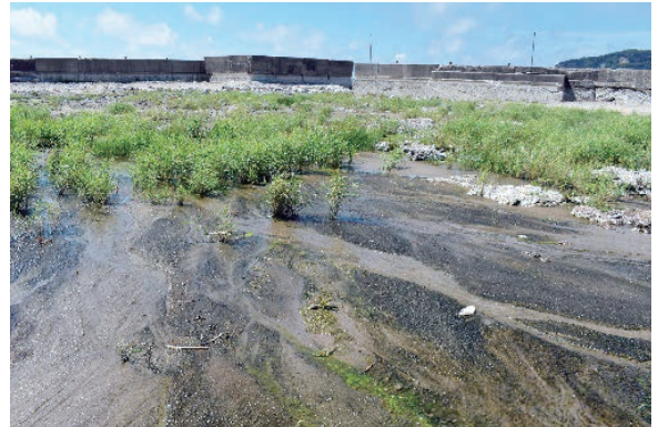
隆起した黒島漁港内の湧水の様子
